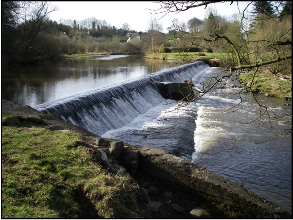
Plate III: Mid Calder Weir
